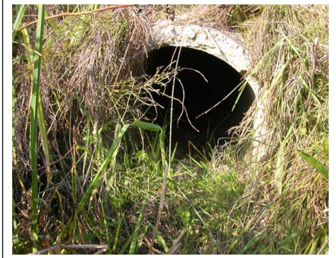
Foto 17: Door een deel van de ronde tunnel op te vullen met zand, wordt het loopvlak voor amfibieën vergroot
