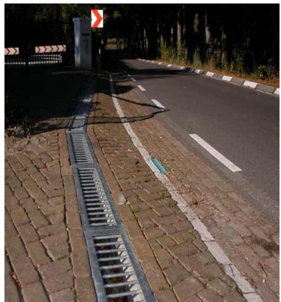
Foto 3b: gebruik van roosters voor de beveiliging van zijwegen
