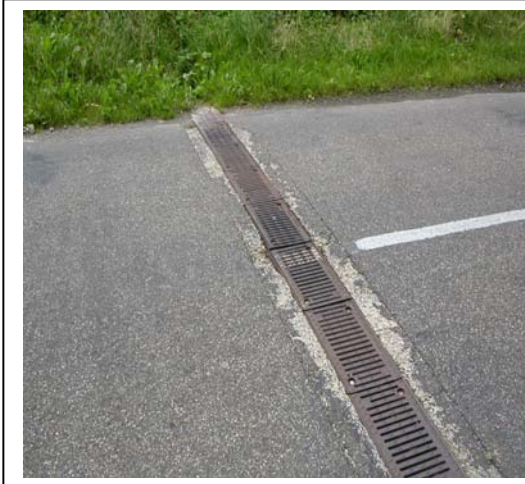
Foto 14: Gebruik van metalen tunnel
