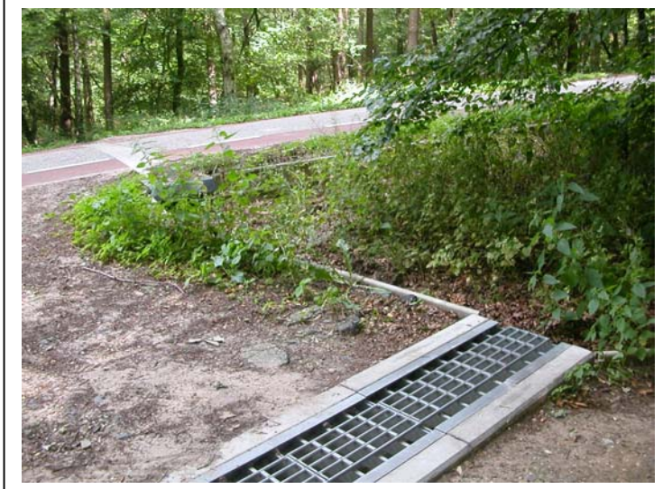
Foto 1: Een geleidingsgoot zorgt voor de beveiliging van zijwegen
