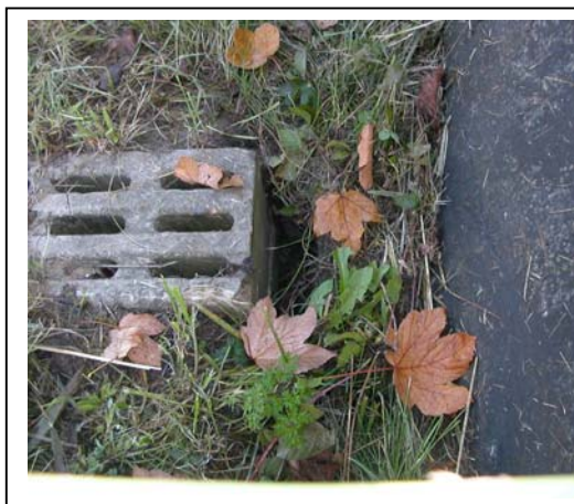
Foto 20: Aansluitelement sluit niet aan op de tunnel
