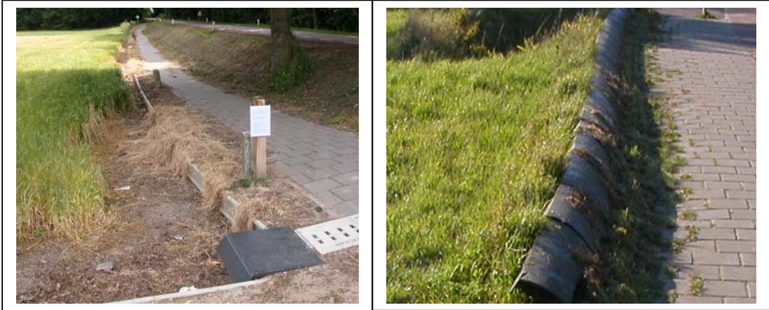
Foto 6 & 7: amfibieën die toch op de weg terug komen, kunnen hier terug achter de geleidingswand keren. Wel is op beide locaties sprake van achterstallig of slecht uitgevoerd onderhoud. Amfibieën kunnen hier via de vegetatie over de geleiding heen klimmen.
