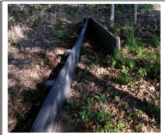
Foto 9: gebruik van een keerelement.
