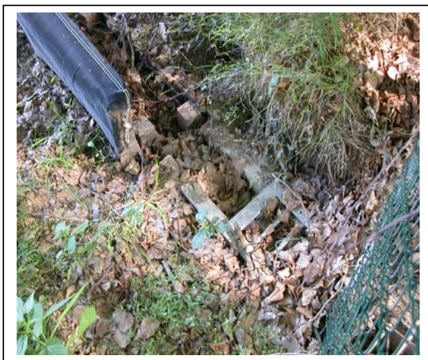
Foto 27: Bladinval bij rooster met grote onderlinge afstand van spijlen
