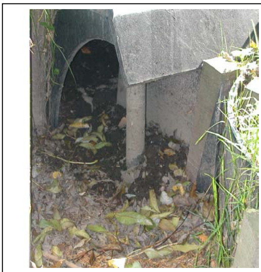
Foto 10: stopwand in combinatie met tunnelingang
