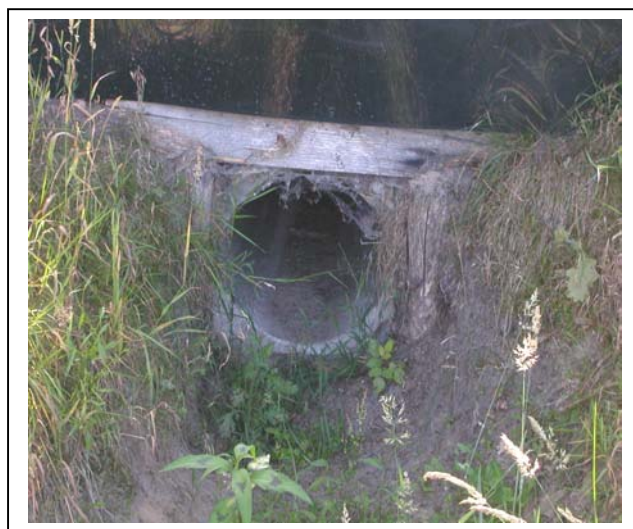
Foto 16: Met het aanbrengen van een (houten) balk, is hier een tijdelijke oplossing gevonden voor het niet aansluiten van de geleiding op een ronde tunnel.
