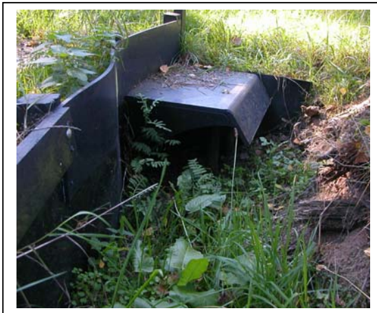
Foto 8: stopelement in combinatie met amfibieëntunnel
