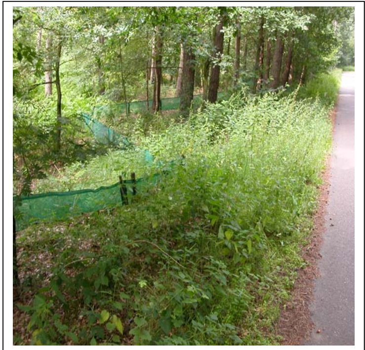
Foto 5: gebruik van een V-vormig geleidingssysteem
