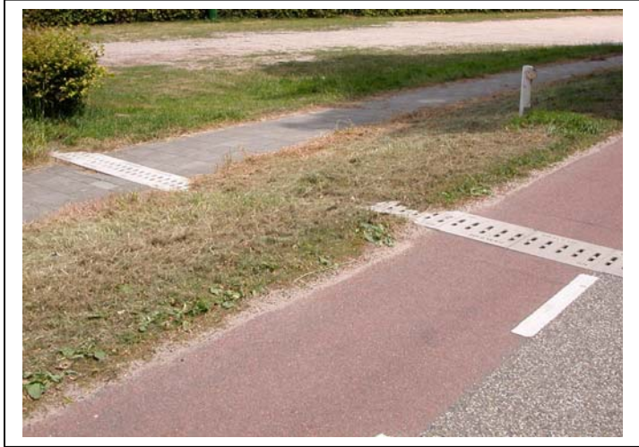
Foto 12: De tunnel loopt hier onnodig lang door onder een berm en een voetpad.
