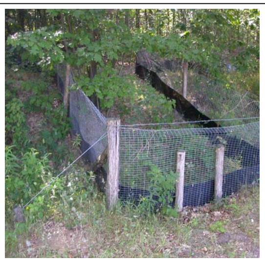
Foto 11: U-vormige geleiding bij de tunnelingang
